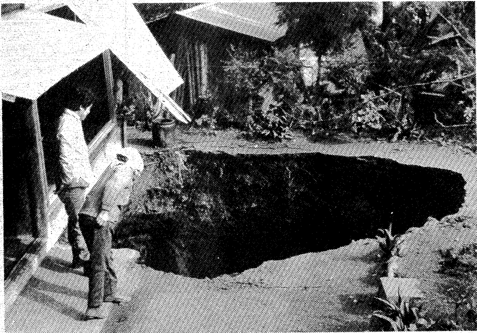
▲去る11日午後、いわき市川部町根小屋の大町雄介さん宅の軒先が直径5m、深さ7mにわたり円筒形に陥没した原因は、地下の廃坑が崩れたもの。東京通産局平石炭事務所では陥没復旧の埋め戻し作業を行い、3日夕に復旧した。
