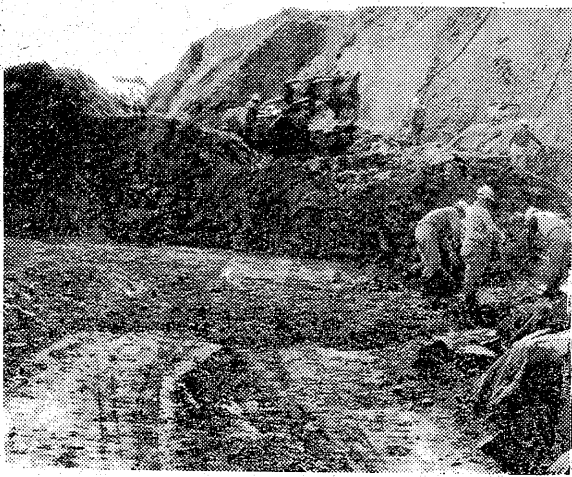
新道の工事現場—永崎地区内
