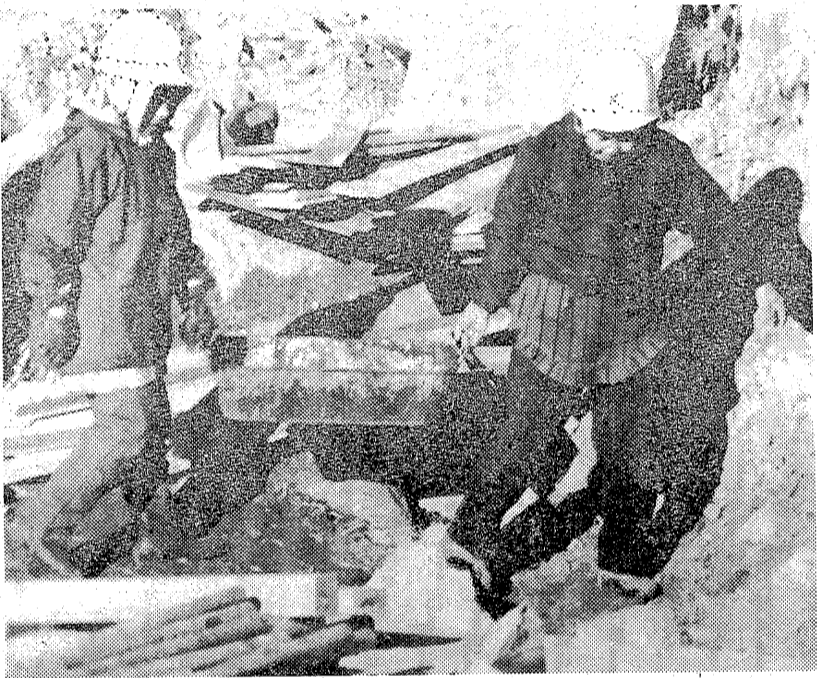
土木工事の軽作業を受け持つかあちゃんたち
