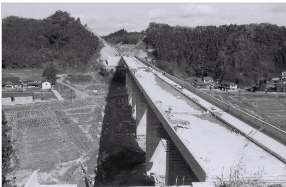
常磐バイパス工事・常磐三沢町付近 (昭和56年12月、いわき市提供)
