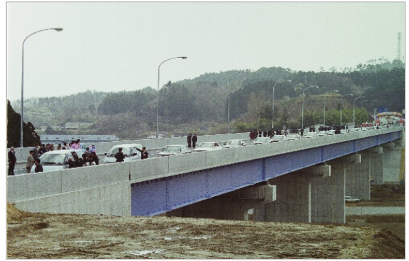
国道6号久之浜バイパス久之浜町久之浜～久之浜町金ヶ沢間開通
