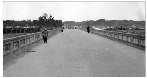
いわき市錦町 鮫川橋付近 (昭和29年頃、磐城国道事務所提供)
