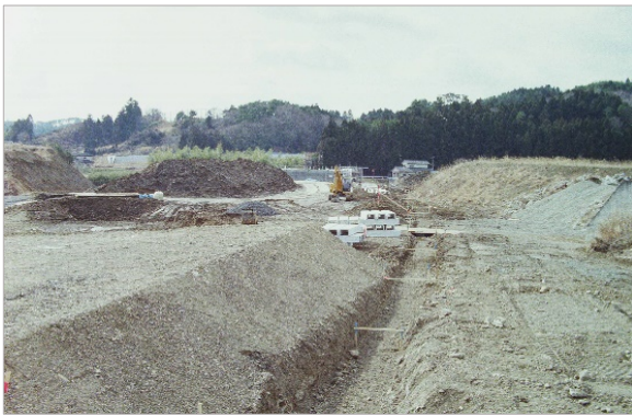
国道6号久之浜バイパス工事
