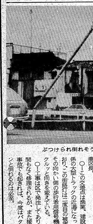
ぶつけられ倒れそうな街路灯
