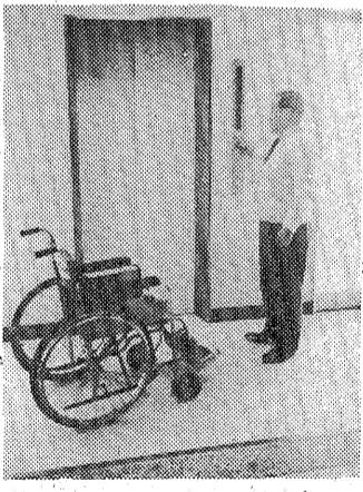
平野市民会館に完成した身障者専用エレベーター
