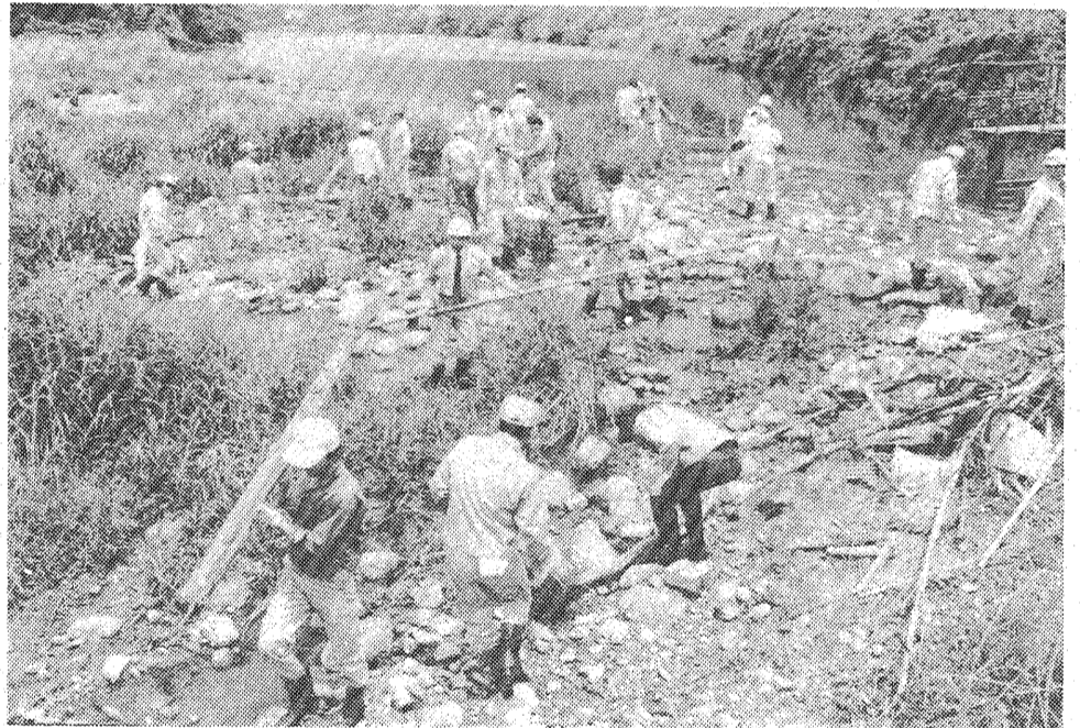
▲4日、市水道局の嶋崎管理者、岡田局長ら78人が、夏井川の小川江筋取水口付近で川の清掃を行った。ここは平浄水場が1日3万6千トンを取水しているところで、みんなは取水口を妨ぐ流木や竹を取り払って焼却。川底のゴミを拾ってはビニール袋へ、そして川岸の雑草を刈り取ったり、慣れない作業にフウフウだった。
