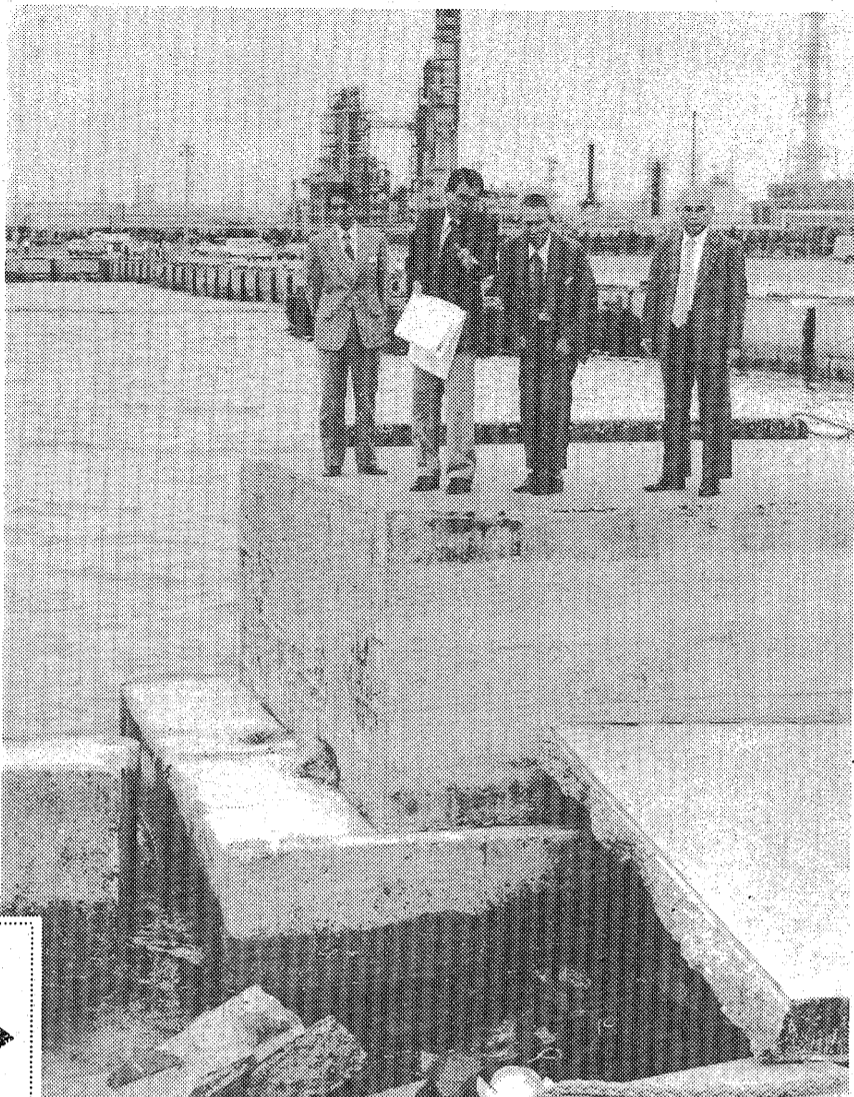
▲田畑市長と松本商工水産部次長の一行は27日、佐藤県小名浜港湾建設事務所長の案内で、先の台風15号で大きな被害を受けた小名浜港の災害視察を行った。なかでも7号防波堤や5、6号ふ頭護岸の決壊や作業船の沈没など、開港いらい最大の惨事となった状況を目のあたりにして、「自然災害の恐ろしさ、を再認識していた。
