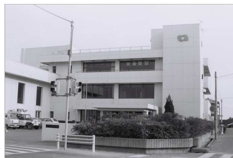
植田公民館 (昭和 56 年 10 月 いわき市撮影)
