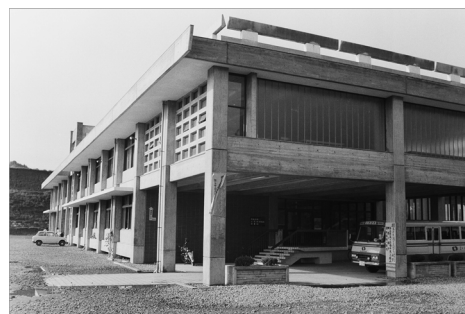
常磐市民会館 (昭和 46 年 9 月 いわき市撮影)
