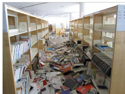
東日本大震災の被害の様子 (平成 23 年 3 月 いわき総合図書館撮影)
