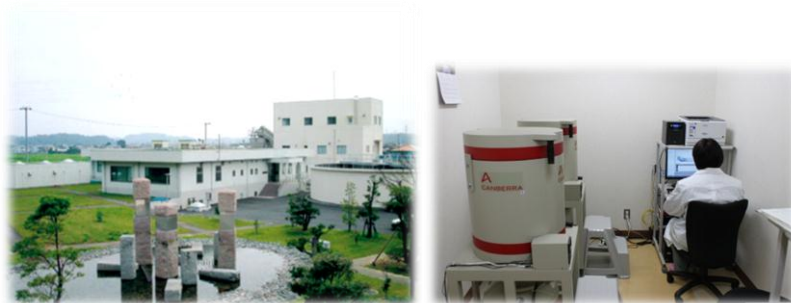
水質管理センターとゲルマニウム半導体検出器 写真提供：いわき市水道局
