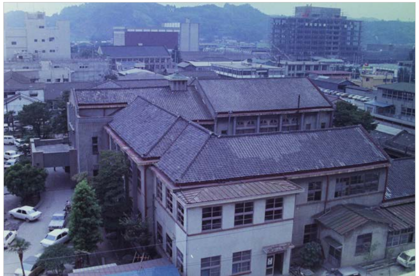
高みから見た平支所、後方には建設中の 市庁舎が見える (昭和 47 年 いわき市撮影)
