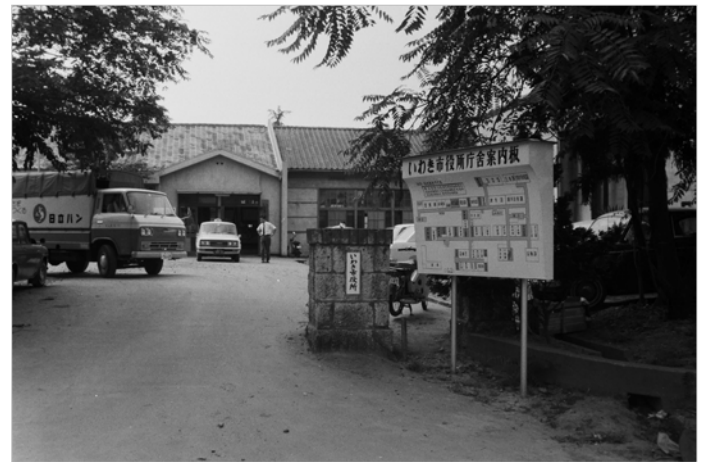
旧平商施設を利用した仮庁舎(昭和44年9月 いわき市撮影)
