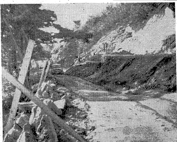
伊佐線の改修工事
