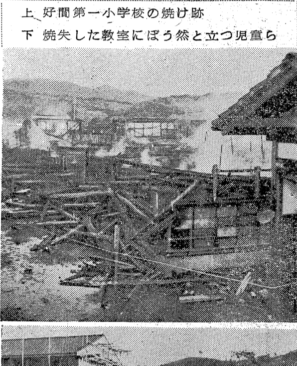
上 好間第一小学校の焼け跡 下 焼失した教室にぼう然と立つ児童ら
