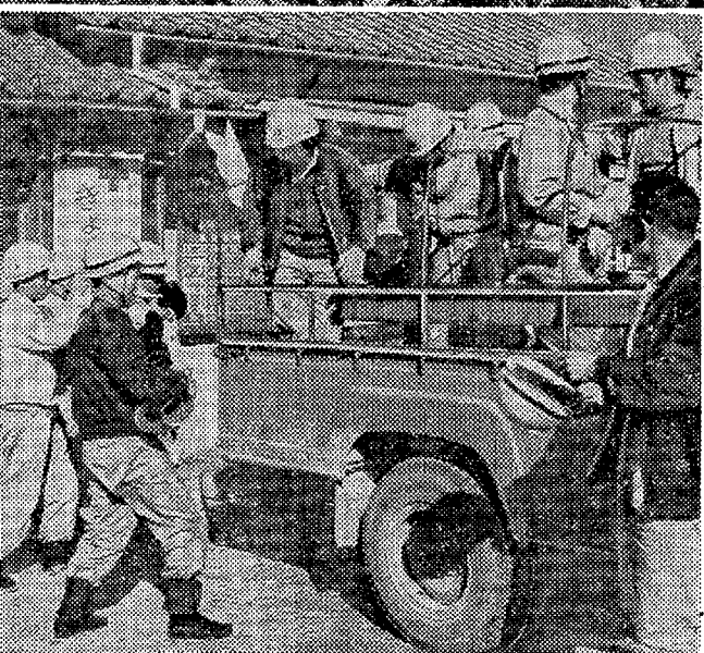
事業所を本畑に現場近くまで機動力を利用 能率を図っている
