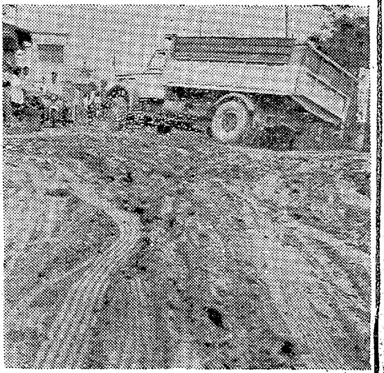
【大型ダンプもハンドルを止めた】 排水路は押しつぶされて排水が悪くなり、雨でも道路は泥沼となり、通行は支障を来し、自動車の通行も遅延を来し、歩行者も通行を止めざるを得ない状態に陥っている。
