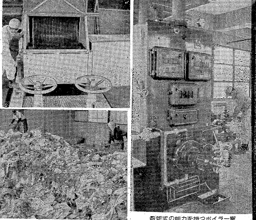
最新式の能力を持つボイラー室
