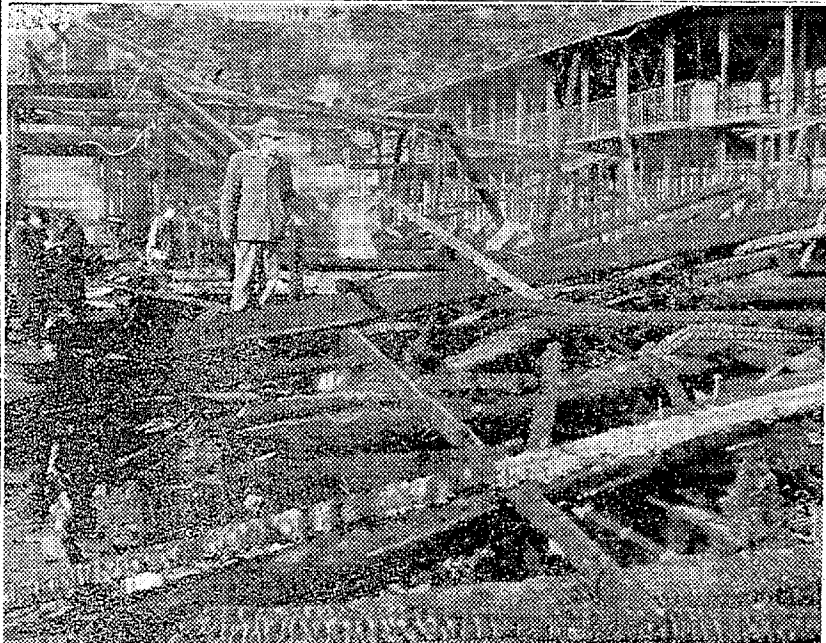
アミふせ部分が全焼した校舎、手前の校舎が校長室、職員室など二番目が新築中の校舎
