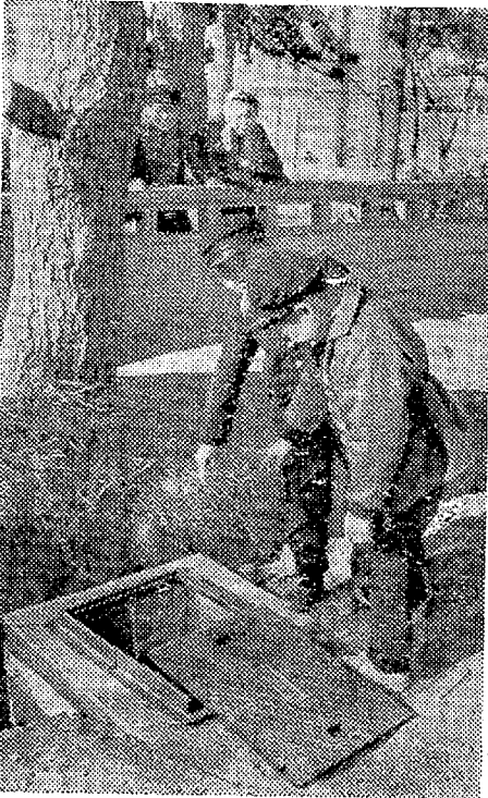
主要な地点に設置された消火せん (草野小前)
