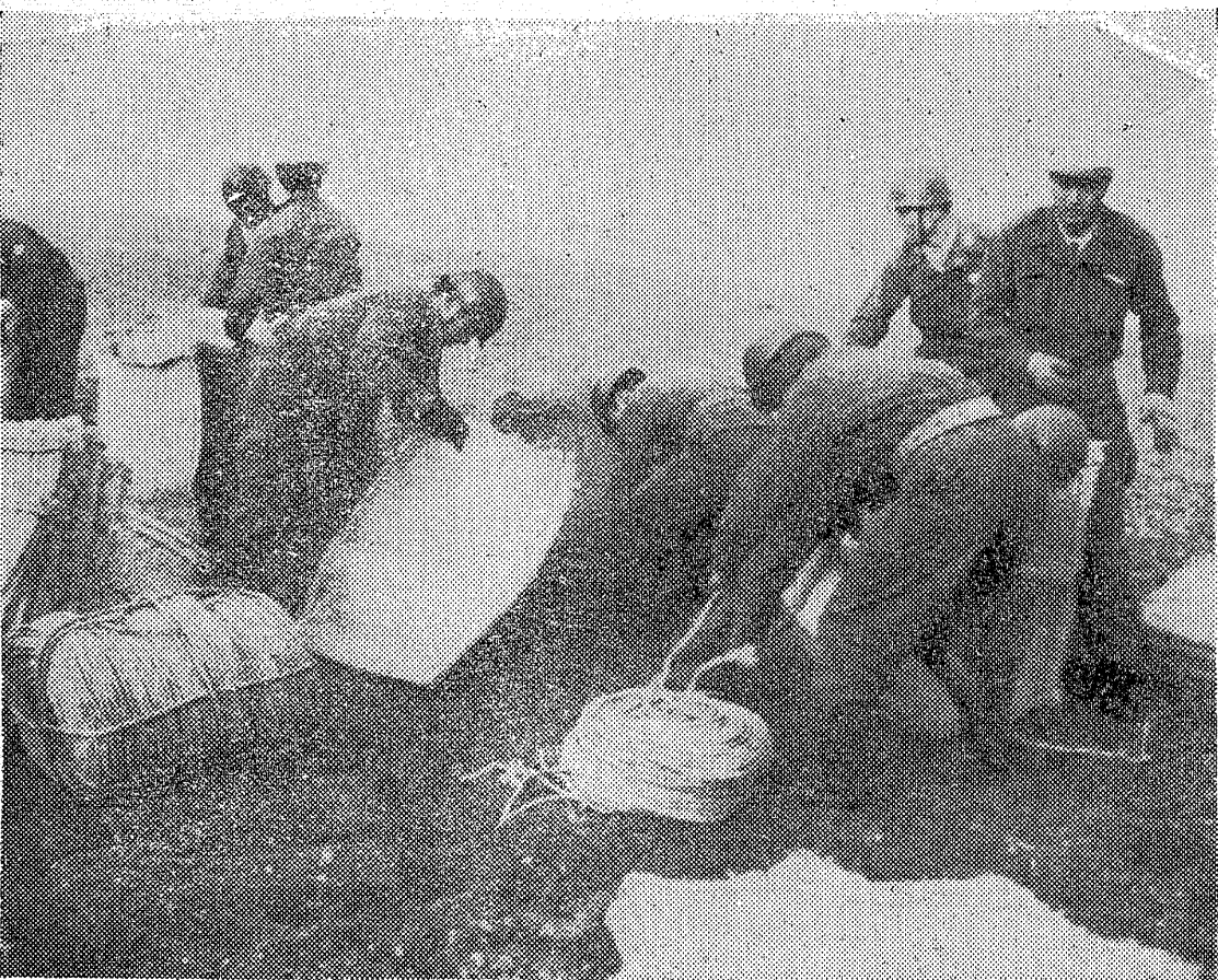
自衛隊も出動して必死の復旧作業
