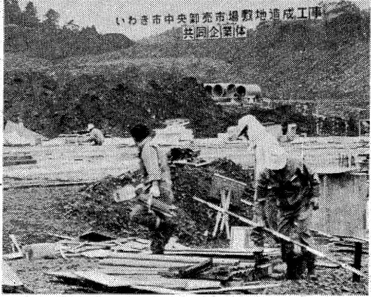
52年春オープンめざし建設の進む中央卸売市場
