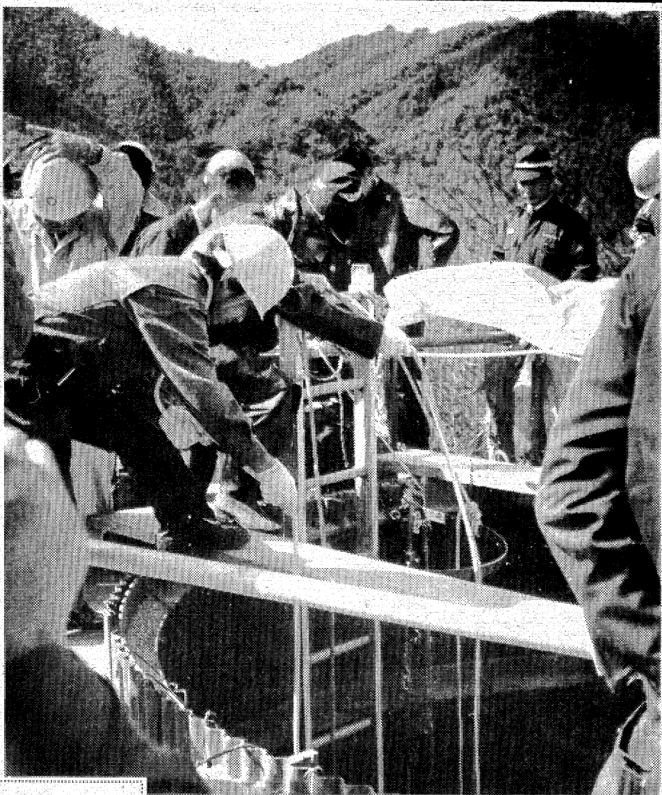
▲10日午前、小川町上小川地内の東京電力鉄塔建設工事現場の脚穴で、作業員2人が死亡、3人が重傷(傷)を負う事故が発生。司法解剖で2人は一酸化炭素中毒死とわかった。このためいわき中央署では、酸欠ではなく、排水用動力ポンプの排ガスによるCO中毒とみて、13日にポンプを動かし、穴の濃度と一酸化炭素を調べた。
