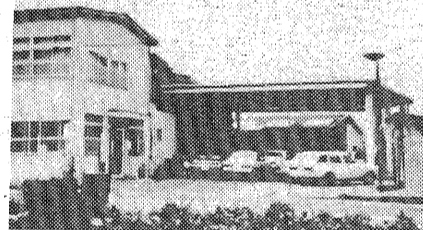
のを、古い倉庫を改造して屋根を 突き出し、米や野菜の出し入れも 安心してできるようになった。事 業費は五百六十三万円。 【広々とした下屋】
