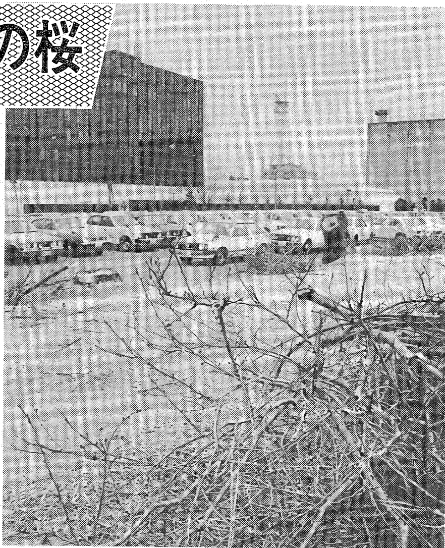
▲バサリと切られた桜並木 河川改修工事のためとはいえ もう 少しなとならなかつたものか? =昭和56年2月13日撮影
