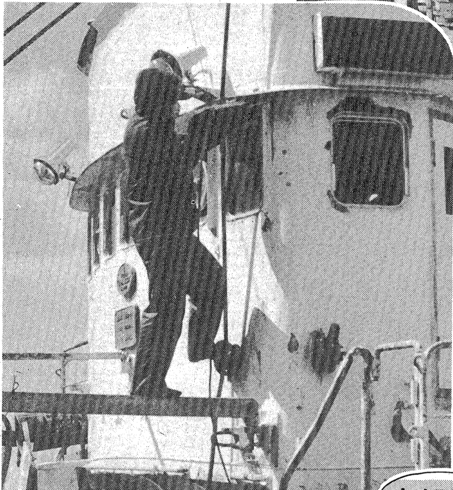
▲北洋の荒波をかぶりながら操業するので船体の傷みが早い。サビ落としや溶接、塗装など少しも手を抜けない＝小名浜造船所で
