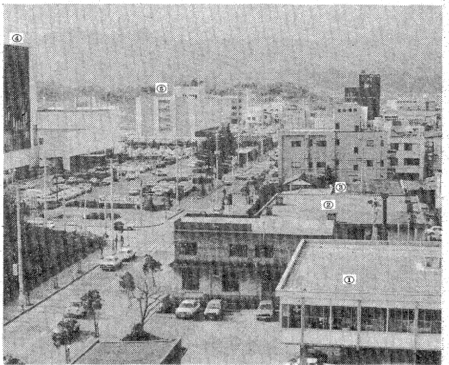
▲いわき市の中枢・平に、①石炭事務所、②職安、③法務局、労基署、食糧事務所など中央官庁の出先機関が入居する、5階建ての「いわき地方合同庁舎」が建設される。場所は職安と石炭事務所の敷地で、近くに④いわき市役所、⑤県合同庁舎があり、58年11月に予定通り完成すれば、この一面はすっかりした行政区画に変身する。
