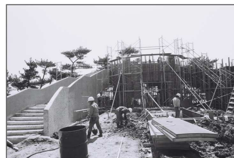
三崎公園の三崎潮見台建設 (昭和53年4月 いわき市提供)
