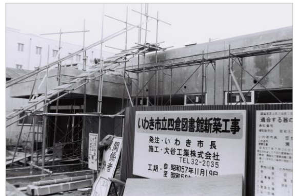
四倉図書館建設風景（昭和 58 年 3 月 いわき市撮影）
