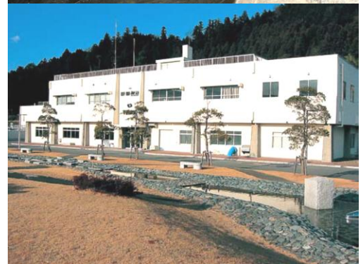
小川江筋取水口(上)と平浄水場(下) 平下平窪 写真提供：いわき市水道局
