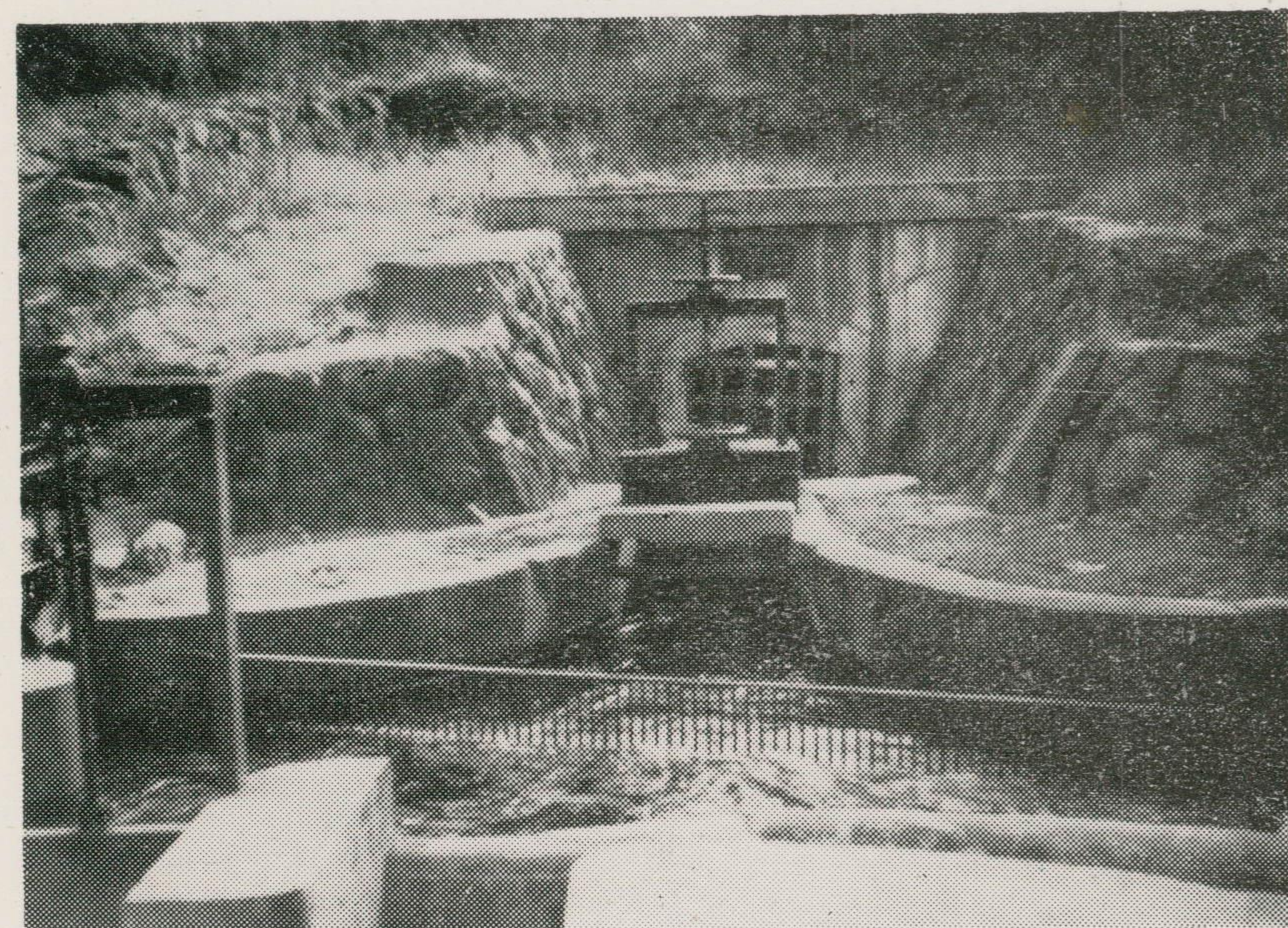
(上水道取入口)
