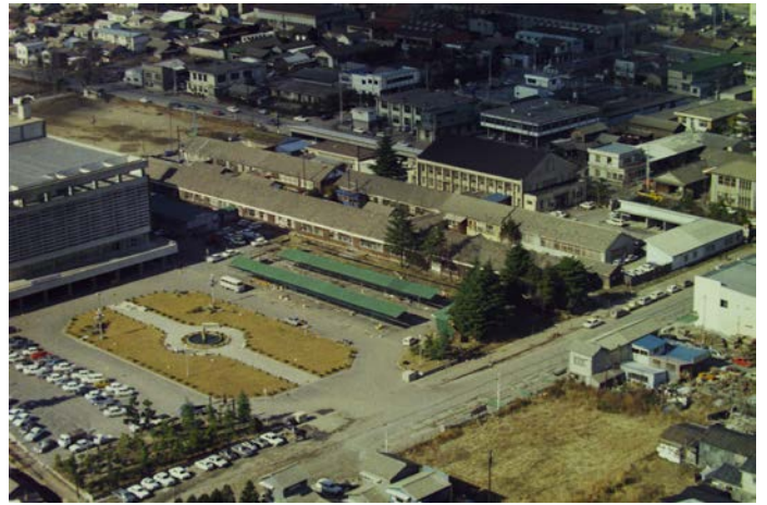
旧平商施設を利用した仮庁舎(昭和48年頃 いわき市撮影)
