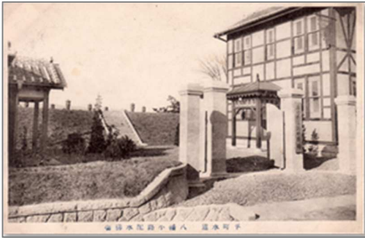
平町水道 八幡小路配水構場
