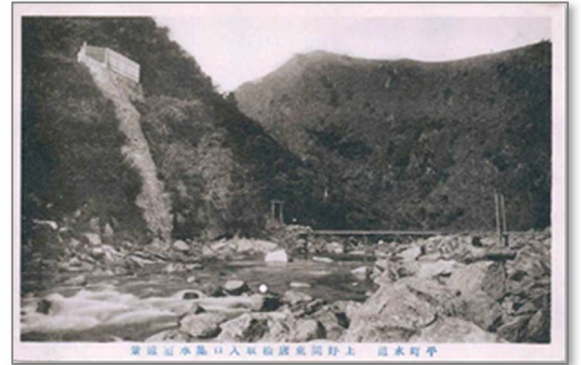
平町水道 上好間東唐松取入口集水室遠景
