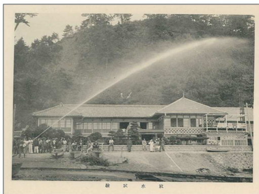
放水試験(四倉町海気館前) 『四倉町上水道抄誌』 四倉町水道部 昭和 12(1937)年
