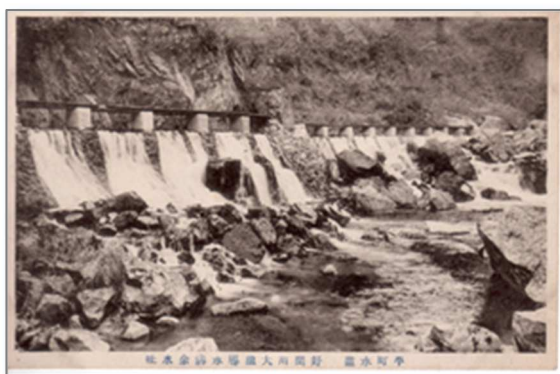
平町水道 好間川大瀧導水溝余水吐
