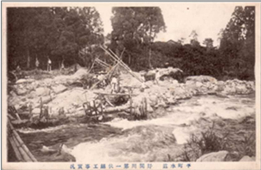
平町水道 好間川第一伏越工事実況
