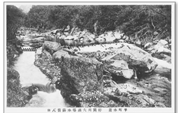
平町水道 好間川大瀧導水引入口
