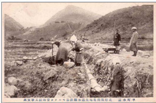
平町水道 北好間残花地先送水線鉄筋モルタル管理設工事実況
