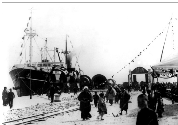
小名浜港3,000トン岸壁（現1号埠頭）に、日本水素建設の資材を積んだ大興丸が入港（昭和13年4月）
