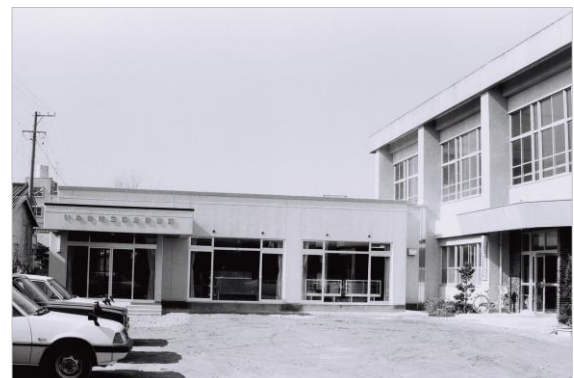
完成した四倉図書館（昭和 58 年 4 月 いわき市撮影）
