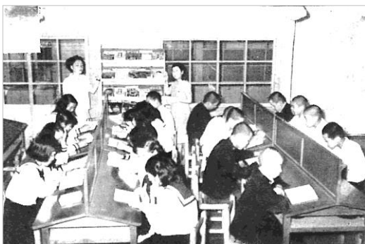
内郷町役場の元会議室を改装し開館した、内郷町立図書館(『内郷町勢要覧 昭和27年度』)
